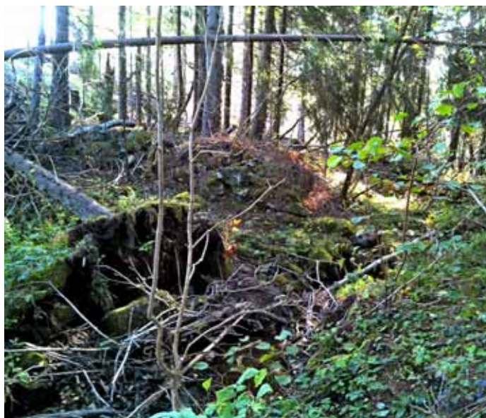
Rester av demning ved Brekkes Mølledam. Foto: Tom Hayden.
